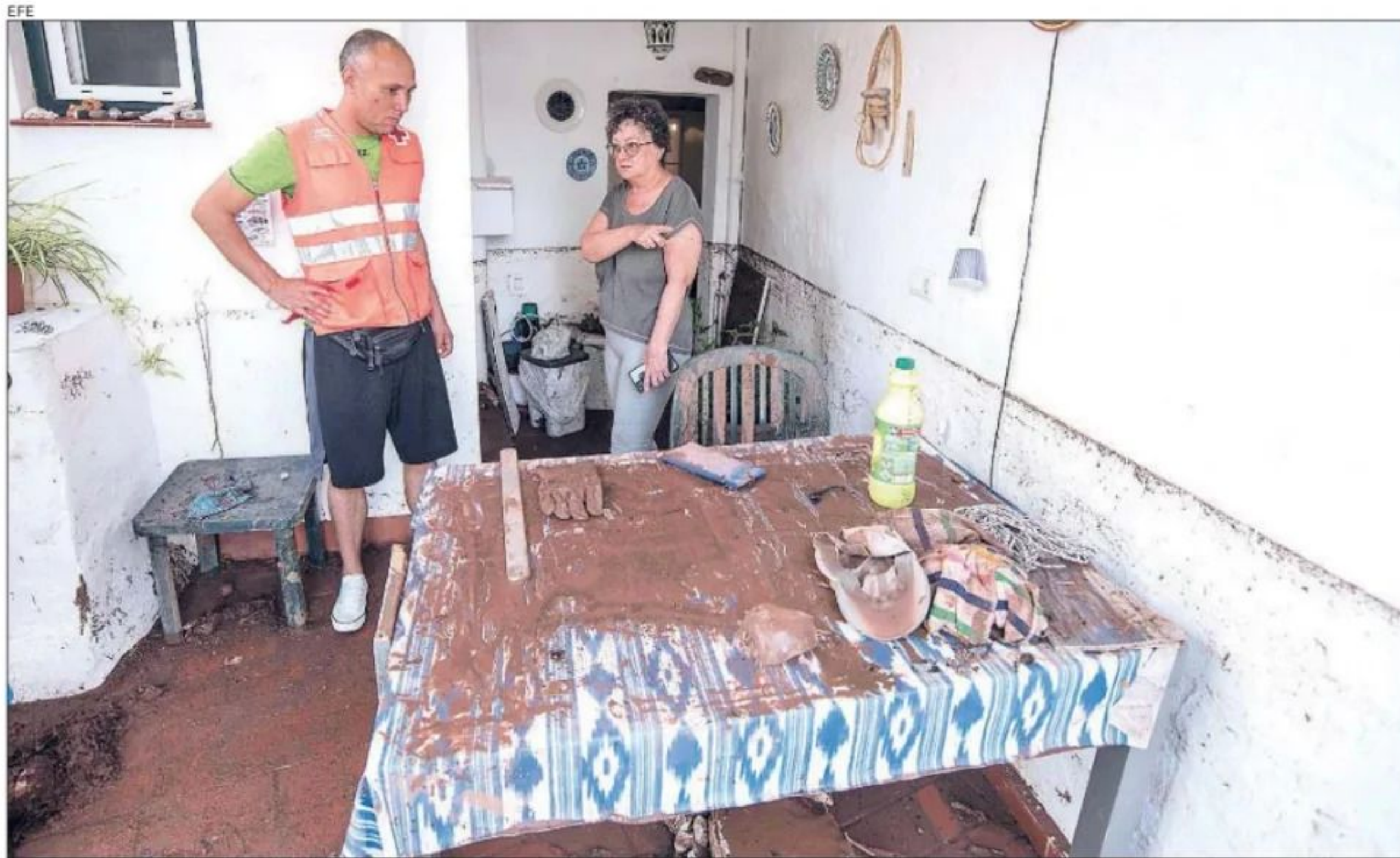
Una de las múltiples viviendas que han sufrido daños en la localidad de Es Mercadal
